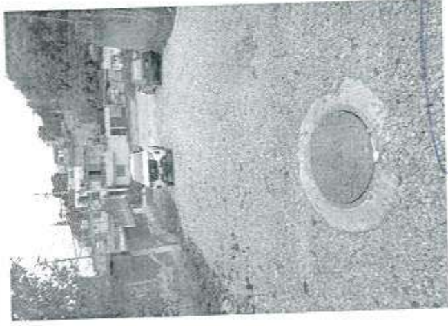
Instalación de brocal de polietileno sobre calle Hueva
